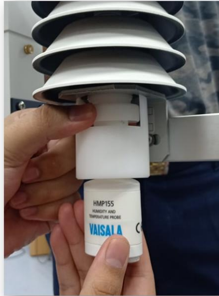
รูปที่ ๓๘ การติดตั้งเครื่องวัดกับอุปกรณ์ป้องกันรังสีจากดวงอาทิตย์
