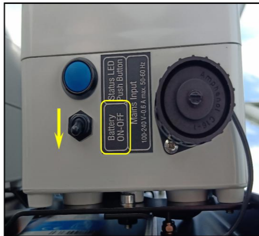
รูปที่ ๕๔ สวิตช์ เปิด-ปิด แหล่งจ่ายไฟให้กับสถานี
